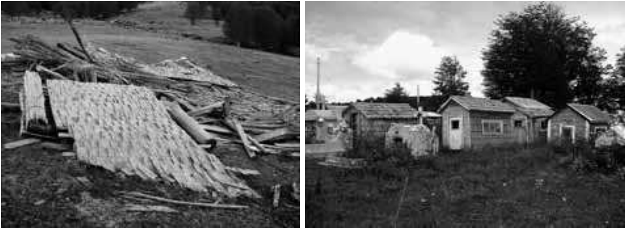
Fotos 5: Construcciones en base a tejuelas artesanales de lenga ( N. pumilio ). De izquierda a derecha: casa desmoronada (construida en 1940), Cerro Negro, provincia de Coyhaique. Nichos en cementerio rural, Lago Pólux, provincia de Coyhaique.
