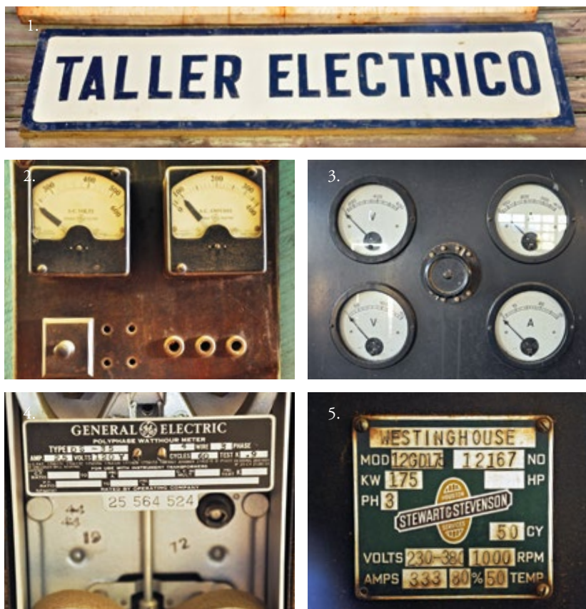
1. Letrero original de Taller Eléctrico 2. Medidores de voltaje 3. Medidores de voltaje y amperaje 4. Placa motor diesel 5. Placa de generador eléctrico | 1. Electricity garage's original sign 2. Voltage meters 3. Voltage and amperage meters 4. Placa motor diesel 5. Electric generator plate
