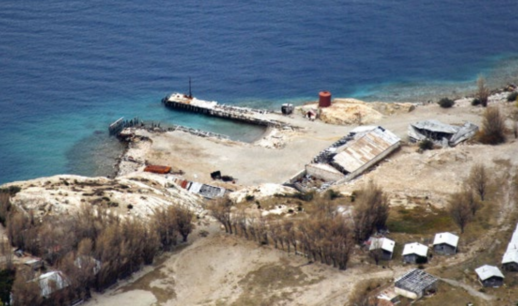
Vista superior del Muelle y de las Bodegas Portuarias | Dock and Port Warehouses overview
