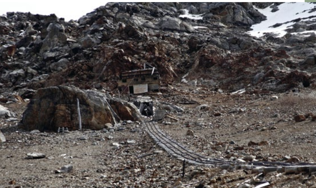
Tramo de rieles hacia acceso Mina Silva | Rail stretch towards Silva Mine's access
