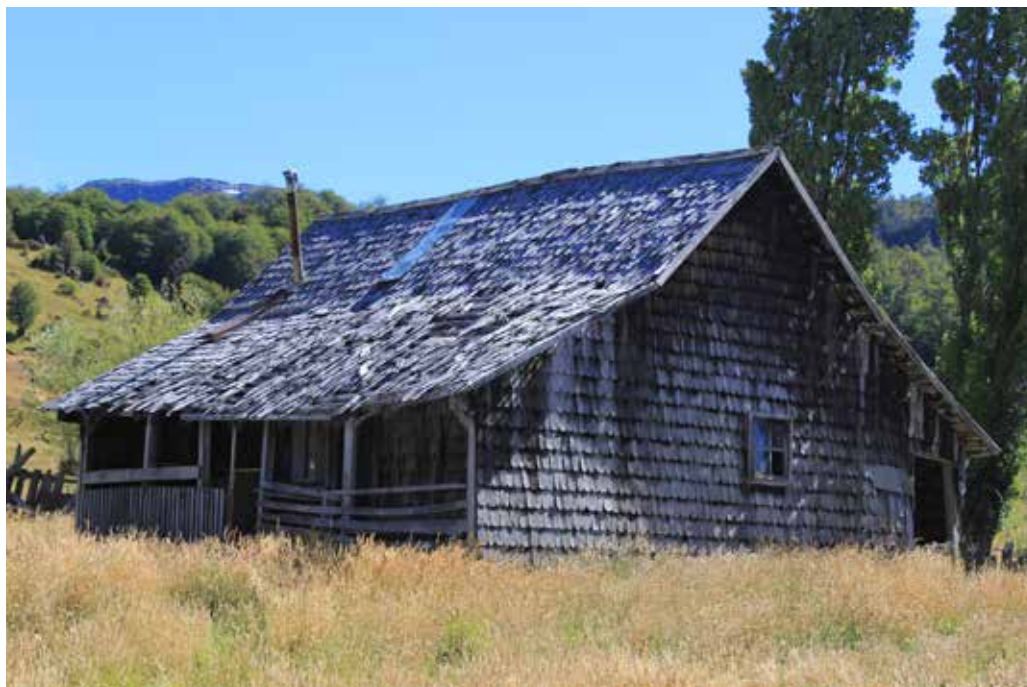
Figura 14. Utilización de la madera y de la tejuela artesanal como material de revestimiento en la arquitectura vernácula, Cerro Catedral - Mina Toqui, comuna de Coyhaique, región Aysén.
