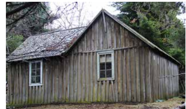
f) uso de la tabla con cinta tapajunta en la pared y tejuela artesanal en el techo, Cerro La Virgen - Coyhaique.
