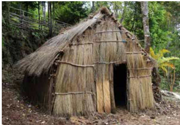
a) uso del junquillo para revestir pared y techo, Repollal medio-Melinka.
