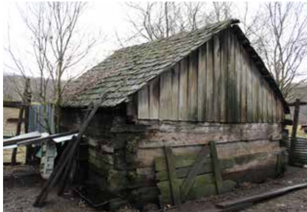
b) uso del palo labrado y baseado -amordazado en pared y la tejuela artesanal en el techo, Seis lagunas-Coyhaique.
