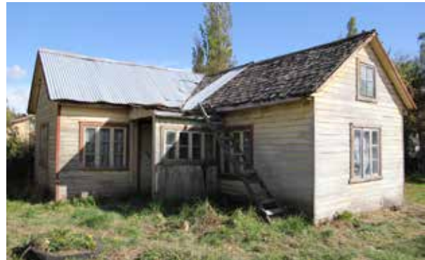
h) uso de la tabla traslapada y el machihembrado en la pared y la tejuela artesanal en el techo, el Salto y Balmaceda-Coyhaique.
