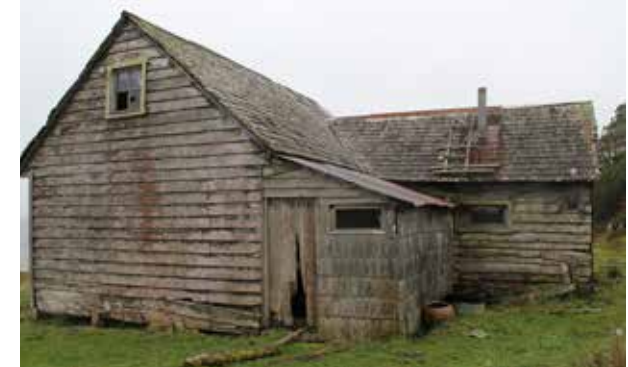
d) uso de la tabla traslapada (tingladillo) en la pared y la tejuela artesanal en el techo, Repollal alto-Melinka.
