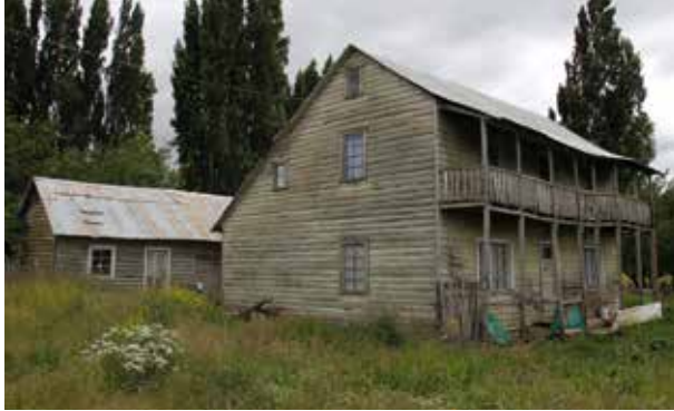
g) uso de la tabla traslapada y el machihembrado en la pared y la tejuela artesanal en el techo, el Salto y Balmaceda-Coyhaique.
